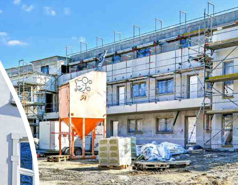
Der Wohnhof Fünfte während der Bauphase
